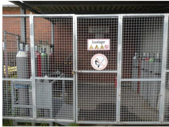
Bild 3 und 4: Gaselager im Freien mit typischer Beschilderung. Bild 3 (links) zusätzlich mit markierter Ex-Zone
