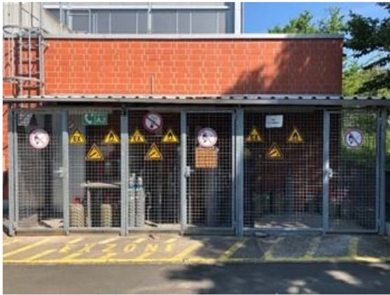
Bild 3 und 4: Gaselager im Freien mit typischer Beschilderung. Bild 3 (links) zusätzlich mit markierter Ex-Zone
