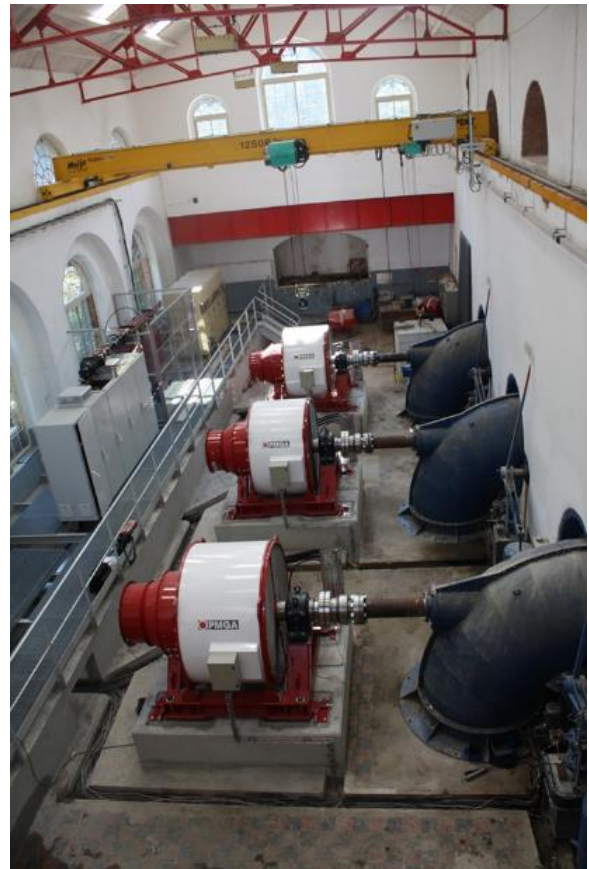
Las Rives HPP 3 Horizontal PMG 800 kW.
